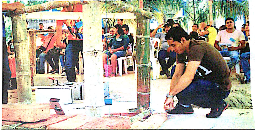
» Uno de los beneficiarios realiza una obra estructural en el cuarto día de taller.
