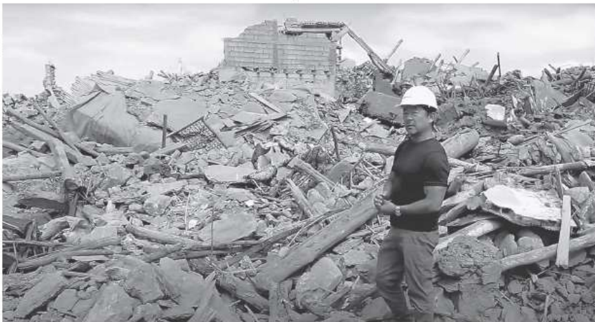
モロッコ地震で被災した山間部のタフェガフテに入った宮本英樹さん。「まず現場へ」を実践する=9月、ミヤモト・インターナショナルの提供動画から
