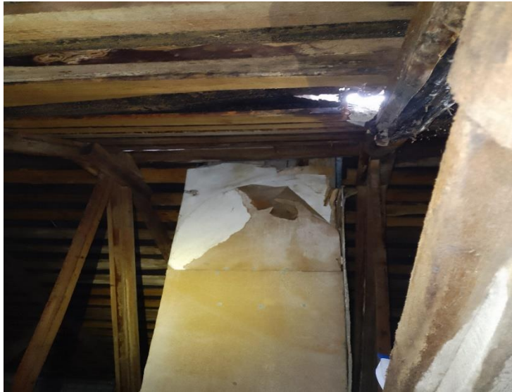
Рис. 5 Використання АВМ для утеплення конструкцій горища будівлі і вентиляційних каналів
