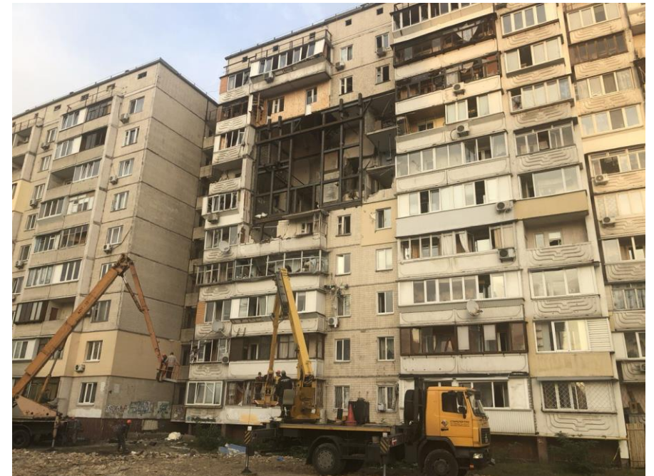
Рис. 3 Приклад стабілізаційних заходів перед демонтажем
