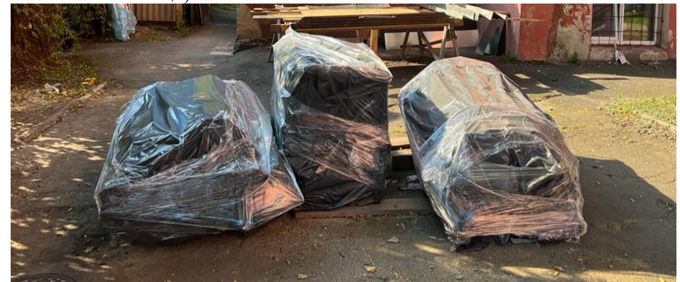
Рис. 15 Приклад пакування азбестоцементних листів
