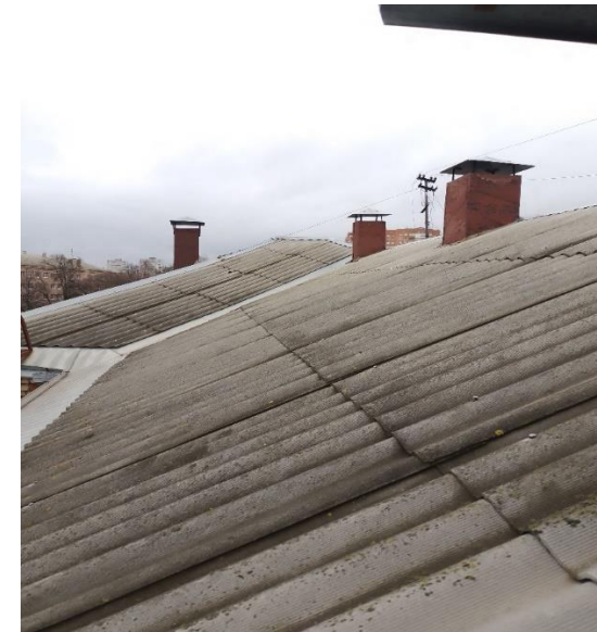
Рис. 4 Приклад використання профільованих азбестоцементних листів в покрівлі будівлі побудованій в 1955року
