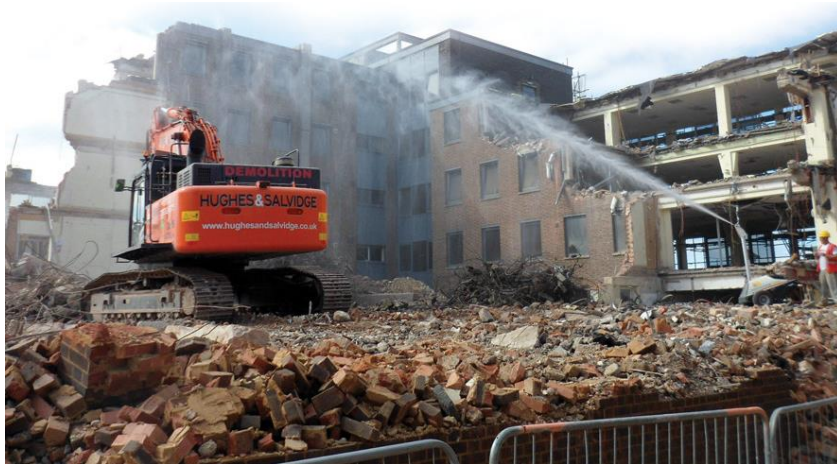
Рис 17. Приклад, безперервного розбризкування води на конструкції що руйнуються (The Construction Index, 2016)
