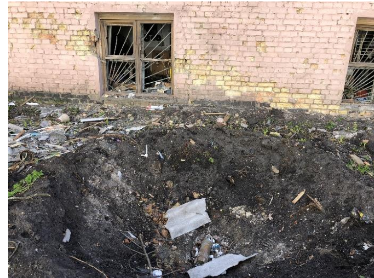
Рис. 18 Залишки азбесту в ґрунті, після потрапляння снаряду.
